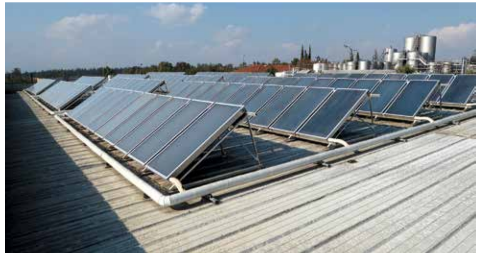
מערכת TIGI שהותקנה ועובדת בהצלחה ביקבי רמת הגולן ומחממת מים ל-85 מ"צ לשטיפת חביות
